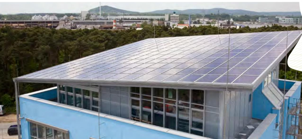
Im Dachfenster des „Blauen Hauses“ sind Solarmodule integriert, die es wie ein riesiges Sonnensegel aussehen lassen.
